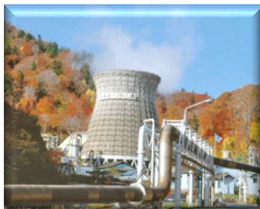
松川地熱発電所（岩手県八幡平市） 写真：JOGMEC「地熱資源情報」より引用
